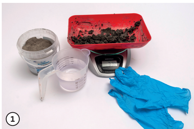
Knetbeton nach Produktanleitung mischen.
