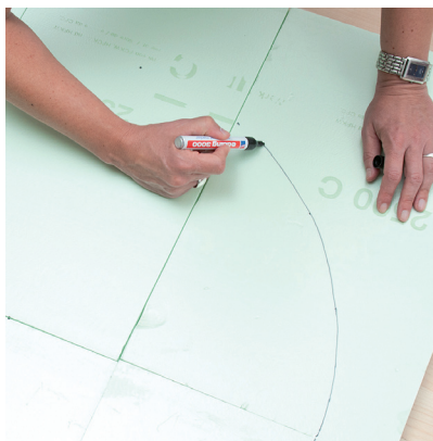
2. Zeichnen Sie, mit einem Meterstab, einen Kreis mit dem Radius von 35 cm (Kreis-ø 70 cm) ein.
